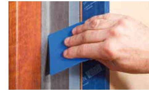
Band auf der Leibung und auf dem Blendrahmen fest anreiben. Besonders effizientes und Händeschonendes Anreiben mit der Anpresshilfe pro clima PRESSFIX.
