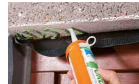
Band mit Klebestreifen auf dem Blendrahmen ansetzen und verkleben. Auf der Leibung Kleberauftrag im engen Zickzack auftragen und Band in den Kleber legen. Fertig zum Überputzen.
