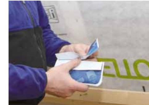
Manschette am Schlitz öffnen
