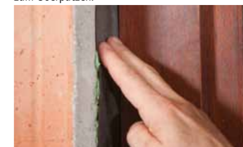
Band im Eckbereich untereinander verkleben. ORCON F bzw. ORCON CLASSIC im engen Zickzack auf Leibung auftragen. Band in den Kleber legen. Fertig zum Überputzen.
