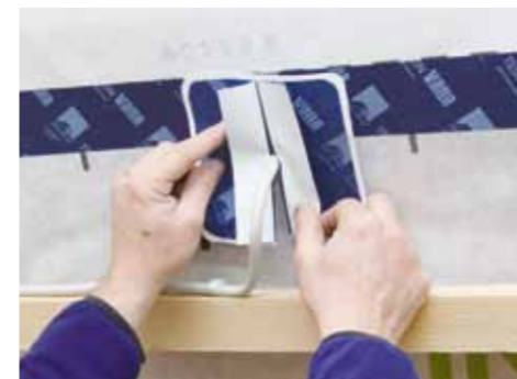
Manschette ausrichten
