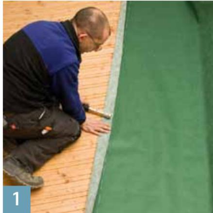
Sind Kehlen vorhanden, zunächst die Bahn hier ausrollen, Randbereich umklappen und mit Klammern fixieren. Im Bereich der Dachfläche erfolgt die Verlegung der Bahnen parallel zur Traufe.
