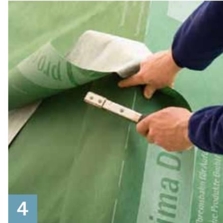
Am First einen ca. 40 cm breiten Streifen DA mittig verlegen. Im Randbereich mit Tackerklammern fixieren. Anschließend luftdicht mit TESCON No.1 / TESCON VANA verkleben. Tackerklammern dabei mit überkleben. Klebebänder fest anreiben.
