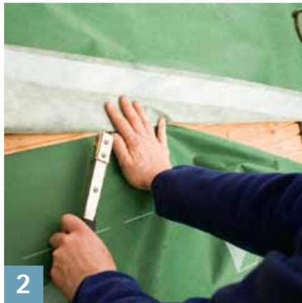
Auf wasserführende 8–10 cm Überlappung der Bahnen achten. Die Befestigung erfolgt im Bahnenüberlappungsbereich mit Tackerklammern im Abstand von max. 10–15 cm.
