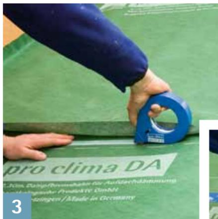
Verklebung der Bahnenüberlappungen erfolgt bei der pro clima DA connect mit den zwei integrierten Selbstklebezonen. Die Bahnenüberlappungen der pro clima DA sowie Kopfstöße werden mit dem doppelseitigen Klebeband pro clima DUPLEX oder dem einseitigen TESCON No.1 / TESCON VANA verklebt. Klebebänder fest anreiben, z. B. mit der Anreihilfe pro clima PRESSFIX.
