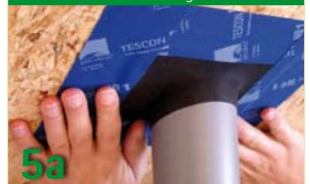
5a EPDM Rohr-Manschette mit dem Allround-Klebeband TESCON No. 1 auf der Luftdichtungsebene verkleben.
