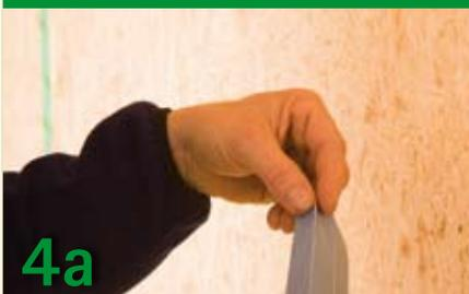
4a Eckanschlüsse z.B. an Fenster, Wände oder Balkendurchdringungen mit Eckklebeband pro clima TESCON PROFIL herstellen.
