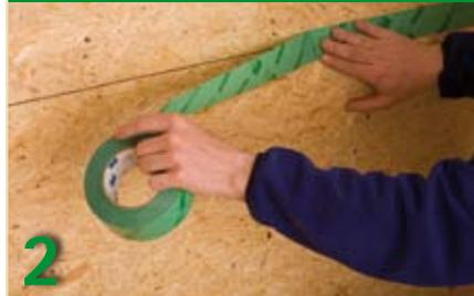
2 RAPID CELL mittig auf der Fuge ansetzen, abwickeln und Plattenstoß Zug um Zug verkleben. Band fest anreiben (besonders einfach mit dem pro clima PRESSFIX)!
