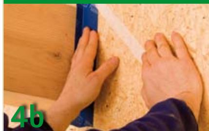
4b Einen Streifen der doppelt geteilten Trennfolie abziehen und ersten Schenkel verkleben. Anschließend die verbliebenen Trennstreifen abziehen und zweiten Schenkel verkleben. Band fest anreiben.
