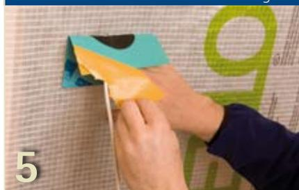
Runde Durchdringungen mit EPDM-Manschetten abdichten. Kabel-Manschetten sind selbstklebend. Rohr-Manschetten mit TESCO No.1 luftdicht an Untergrund verkleben. Klebebänder fest anreiben.
