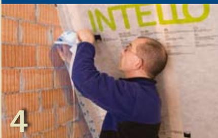
Definierter Putzanschluss mit pro clima CONTEGA PV. Vlies mit Klebestreifen an Bahn und mit ORCON F punktuell am Mauerwerk fixieren. Armierung und Vlies in die Mittellage des Putzes einbetten.
