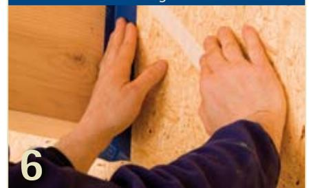
Eckanschlüsse mit dem Eckklebeband pro clima TESCO PROFIL herstellen. Einen Streifen der doppelt geteilten Trennfolie abziehen und ersten Schenkel verkleben. Anschließend verbliebene Trennstreifen abziehen und zweiten Schenkel verkleben.
