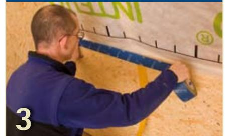
Für luftdichte Anschlüsse von Dampfbremsen an glatte, nicht mineralische Untergründe wie z.B. Holzwerkstoffplatten oder gehobeltes Holz TESCO No.1 mittig ansetzen und Zug um Zug verkleben.
