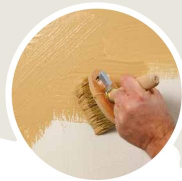
CLAYFIX Lehm-Anstrichstoffe werden von einer Kombination aus Ton und pflanzlichen Mitteln gebunden, sind wasserlöslich stabilisiert.
