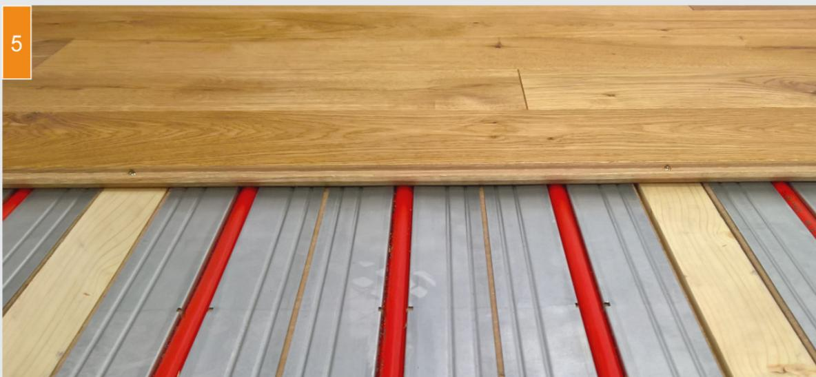
(5) Ein geeigneter Holzboden wird verlegt.
