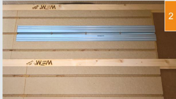
(2) Wärmeleitbleche werden in die Verlegeplatten eingelegt.
