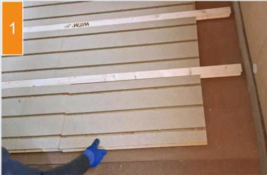
(1) Die Holzfaser-Verlegeplatten und Profilleisten werden ausgelegt.
