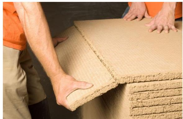
Abb. 4: Brechen der Platte über eine Kante und Durchtrennen des Gewebes
