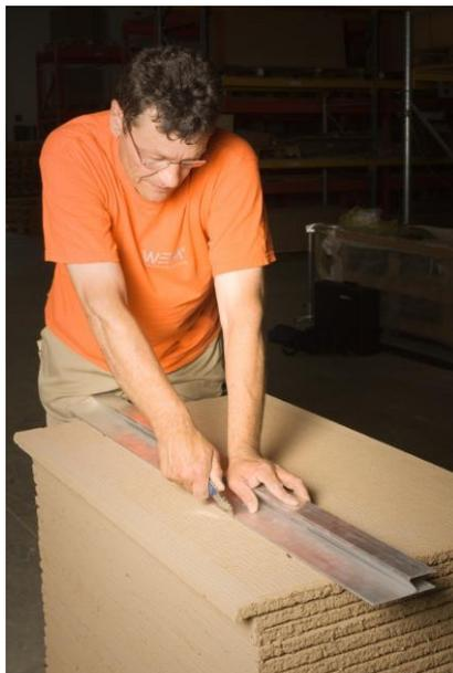
Abb. 3: Zuschnitt der Platten mittels Cuttermesser
