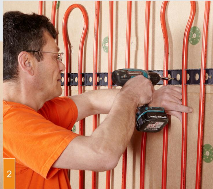
(2) Das nächste Klimaregister wird ebenfalls am Untergrund befestigt und mit dem ersten verbunden.
