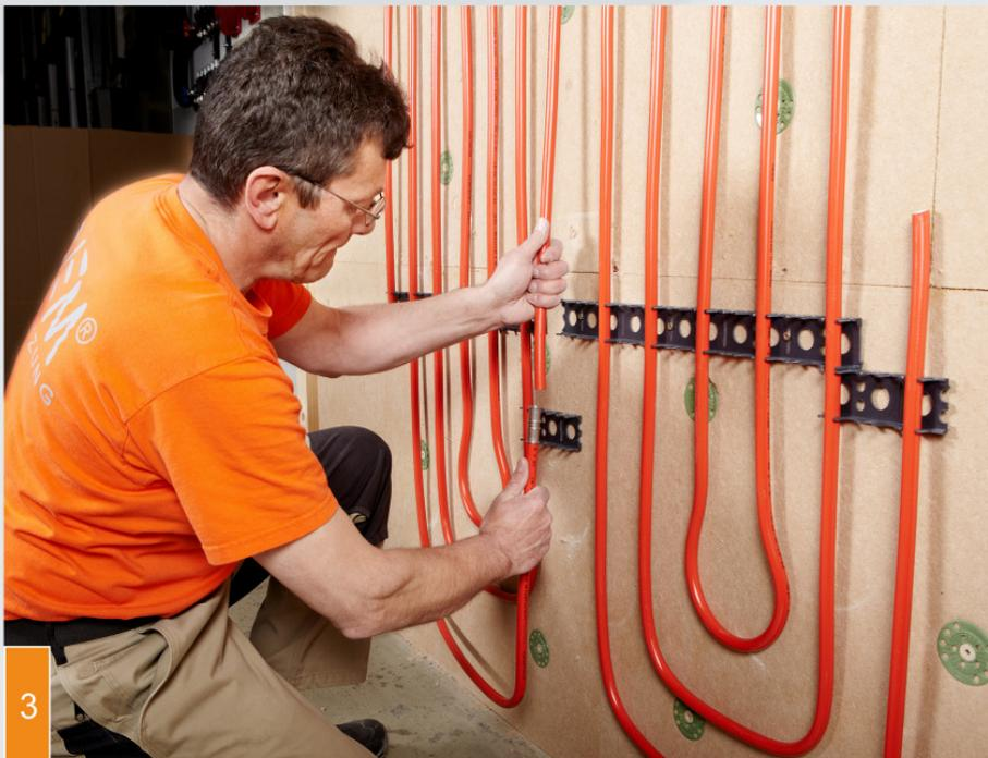
(3 und 4) Die Register werden mit WEM® Pressfittings verbunden und verpresst.
